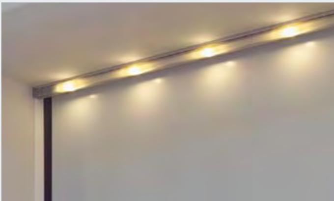
LED-Lichtleiste am Sturz montiert
